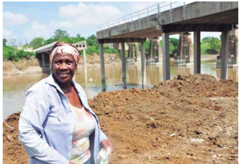
Más de tres décadas en la construcción no le impiden a Isabel continuar a pie de obra. /Foto: Vicente Brito
