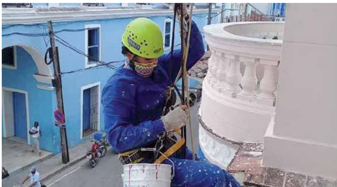
La fachada de la institución ha exigido de la utilización de la técnica de alpinismo. /Foto: Odalys Cid
