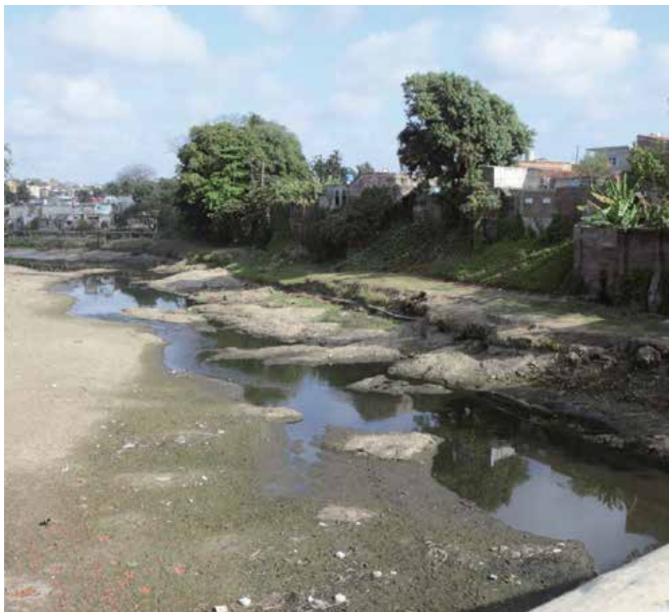
Los bajos niveles en el cauce del río Yayabo inciden en la inestabilidad del abasto de agua en la ciudad espirituaña. /Foto: Vicente Brito
