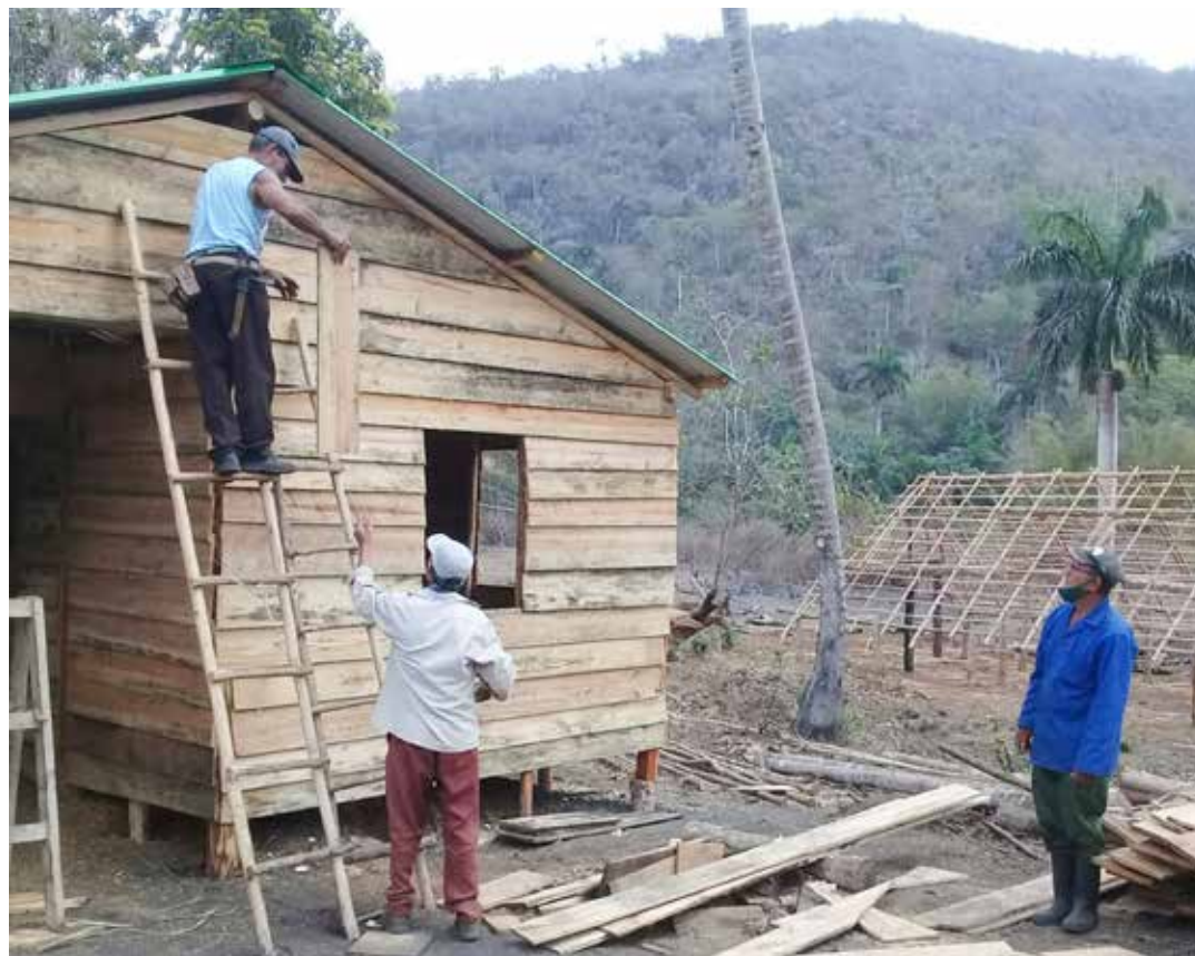
En una primera etapa se edifican 20 viviendas para asentar fuerza de trabajo en áreas de interés forestal y agropecuario.
