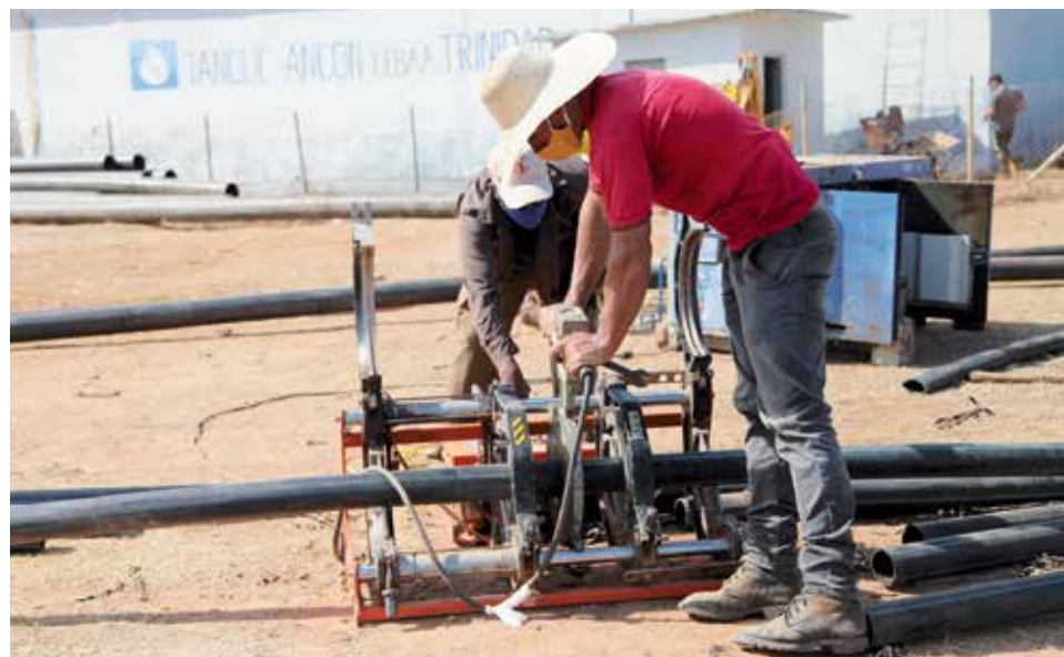
Los constructores avileños trabajan en las redes internas de la ciudad. /Fotos: Oscar Alfonso
