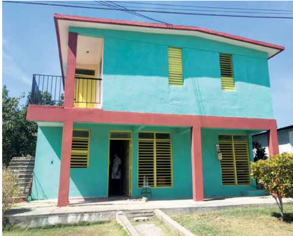
Alrededor de una decena de consultorios médicos del Plan Turquino han recibido los beneficios de la reparación y el mantenimiento. /Foto: Dayamis Sotolongo
