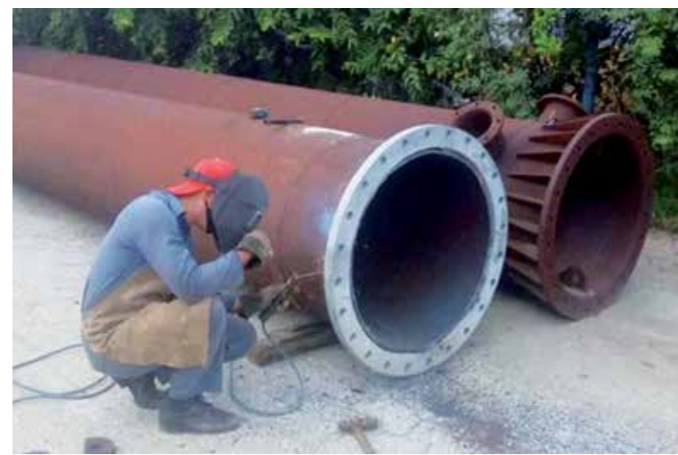
Alrededor del 70 por ciento de la ciudad, que se abastece de la Planta Potabilizadora Macaguabo, presentará afectaciones en el servicio de agua. /Foto: Franklin Lantigua
