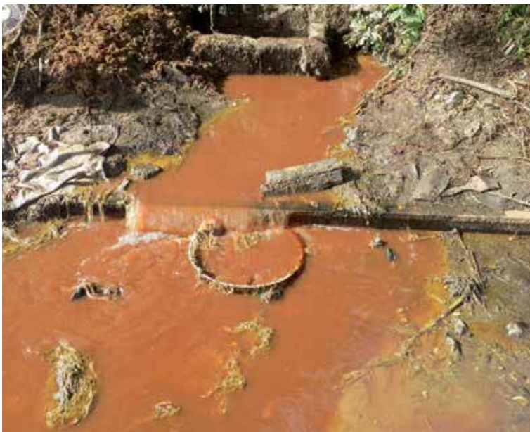
En varias partes los rieles están sin base sólida debido al vertimiento de aguas provenientes del matadero Víctor Ibarra.
