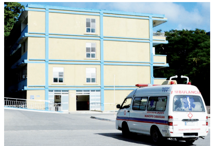
La unidad en construcción permitirá ampliar los servicios médicos de la principal institución hospitalaria de la provincia. /Foto: Vicente Brito
