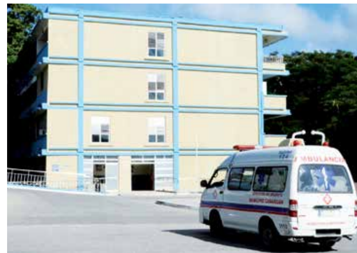
La unidad en construcción permitirá ampliar los servicios médicos de la principal institución hospitalaria de la provincia. /Foto: Vicente Brito
