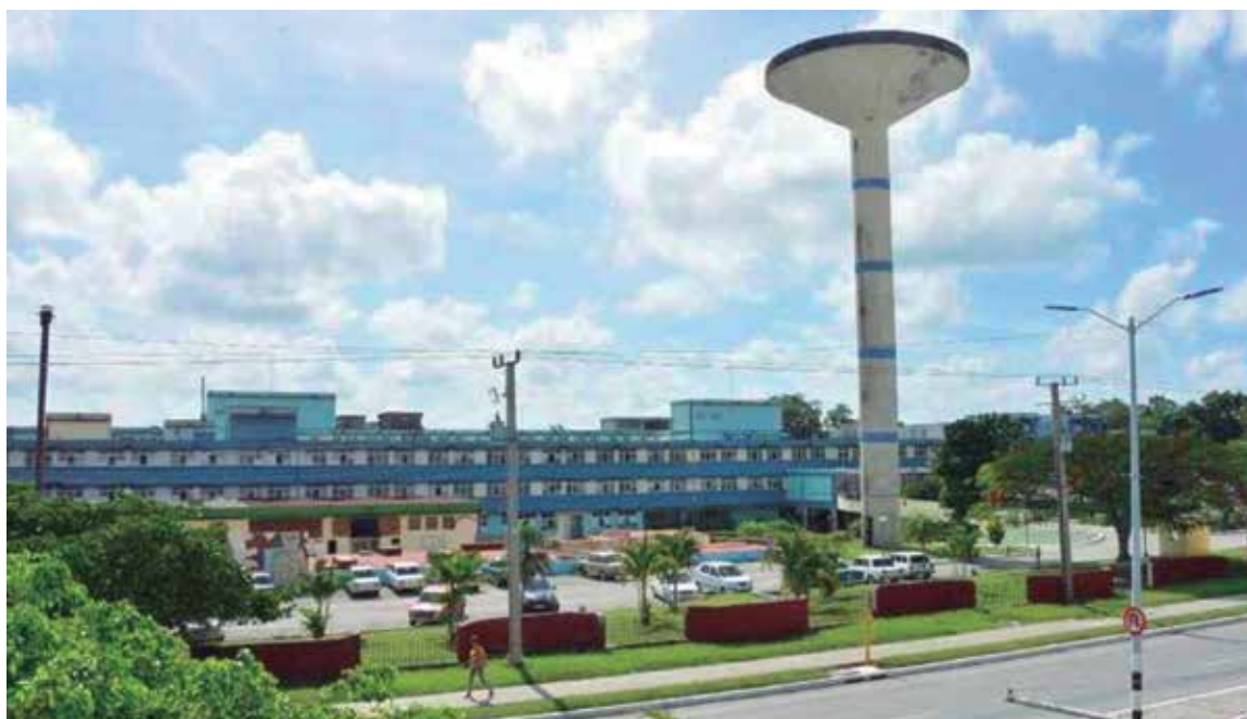
Las anomalías con el suministro de agua al centro asistencial es una insatisfacción permanente. /Foto: Vicente Brito
