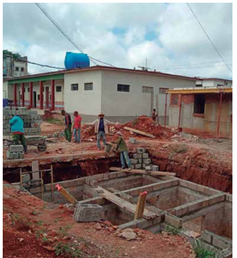
Brigadas constructoras del sector no estatal, tanto del municipio de Trinidad como de Sancti Spíritus, asumen el grueso de los trabajos.
