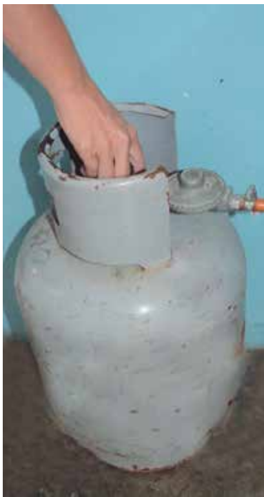
Ante la sospecha de salidero se debe cerrar la llave del cilindro. /Foto: Vicente Brito
