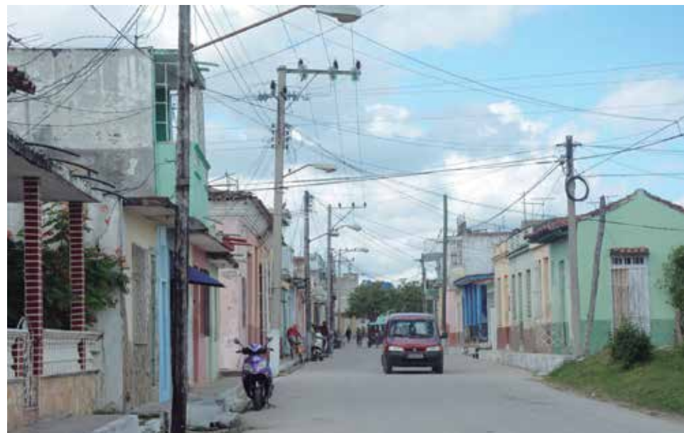
La desconexión parcial del alumbrado público está entre las medidas adoptadas en la provincia con vistas al ahorro de electricidad. /Foto: Vicente Brito
