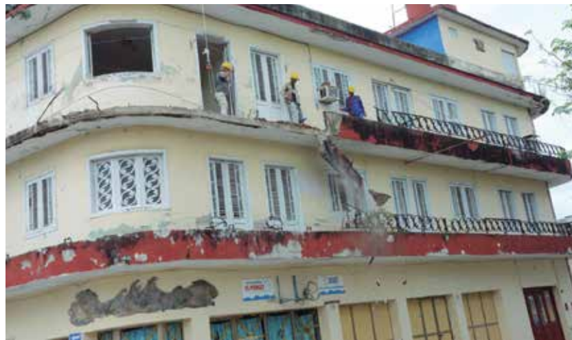
Con mucho cuidado se realizan las labores de demolición. /Foto: Vicente Brito
