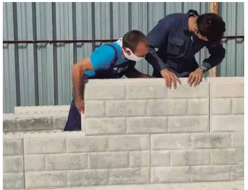
Las minindustrias de Yaguajay aseguran los materiales para la ejecución de viviendas. /Foto: NTV
