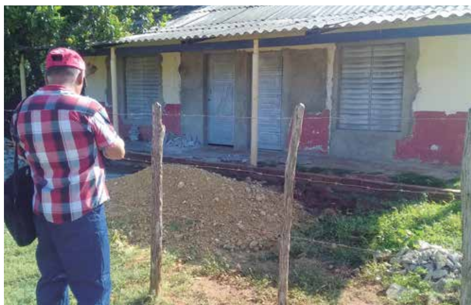
A punto de concluirse está la reparación del consultorio y la casa del Médico de la Familia.
