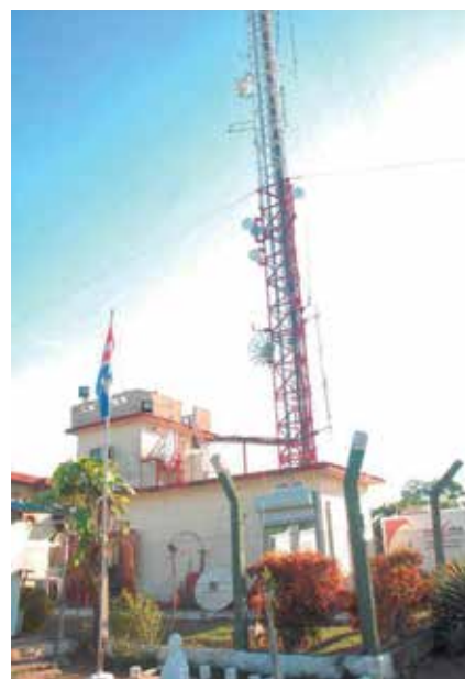
La falta de fluido eléctrico en San Isidro afecta considerablemente la señal radiotelevisiva en el territorio. /Foto: Reidel Gallo
