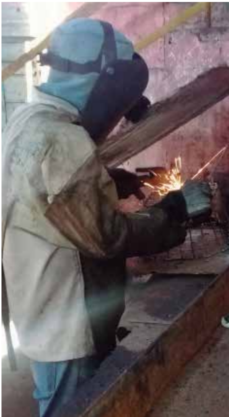
Cerca de 200 trabajadores participan en las reparaciones.
