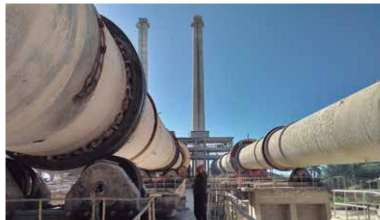
Tras su arrancada, la industria ha producido más de 500 toneladas de cemento.
