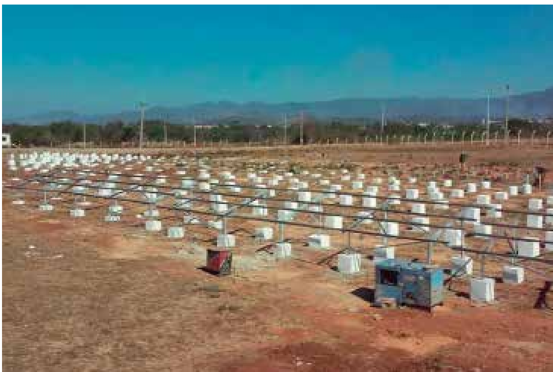
El parque solar fotovoltaico que se construye en Trinidad aportará 2.2 MW. /Foto: Leonardo Campos
