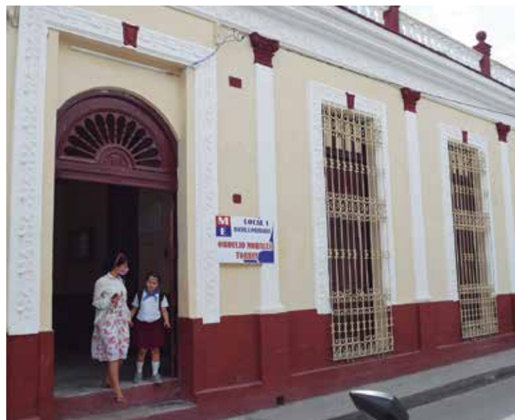
La escuela primaria Obdulio Morales recibió los beneficios de una reparación capital. /Foto: Yoan Pérez
