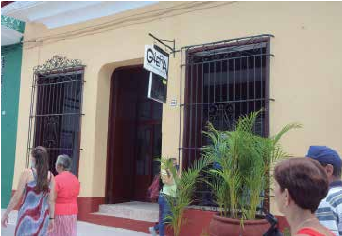
La reparación de la casona se extenderá hasta el 2025. /Foto: Vicente Brito
