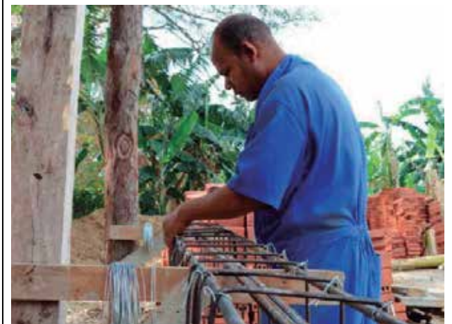
Se trabaja en la recuperación de los hornos en varios tejares de la provincia. /Foto: Vicente Brito
