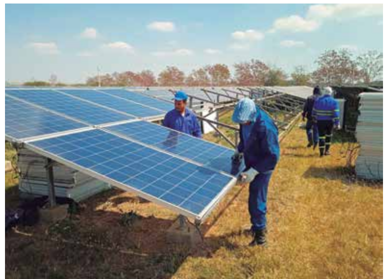
En el parque solar fotovoltaico de La Sierpe se sustituyeron 1 200 paneles.
