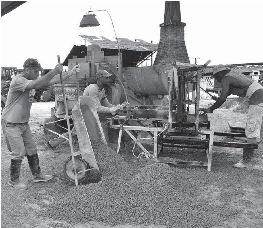
En el Combinado Dolores, de Cabaiguán, no se ha detenido la producción de bloques con destino a la Vivienda.
