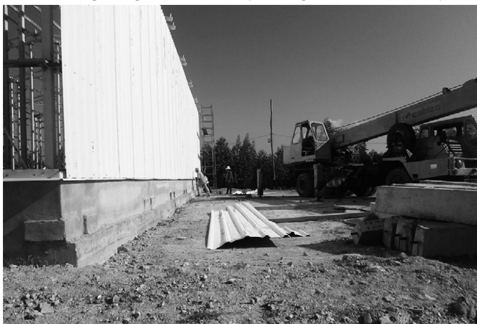
Constructores se encuentran en la fase de montaje de las estructuras metálicas de tres de las naves de la escogida de Jíquima.
