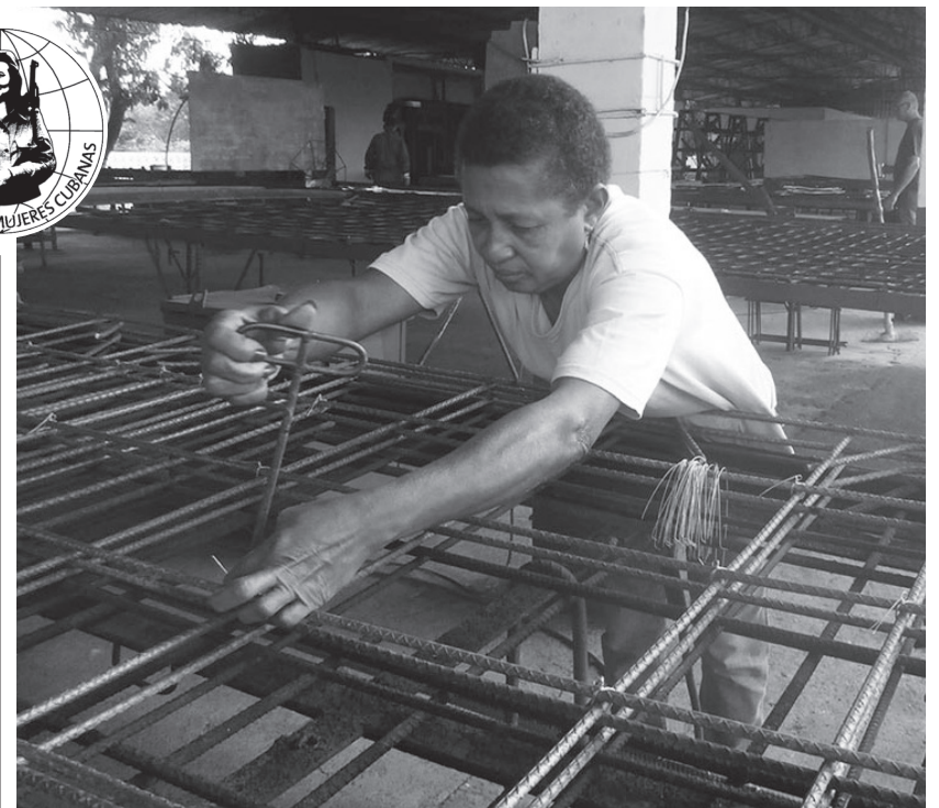
Las manos de Mayda unen las mallas para fundir paneles de hormigón.
