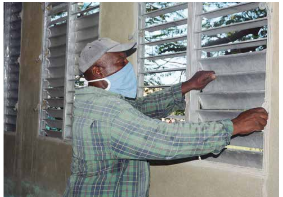
Brigadas constructoras del territorio emprenden varios objetos de obra para mejorar el confort de la instalación deportiva. /Foto: Vicente Brito
