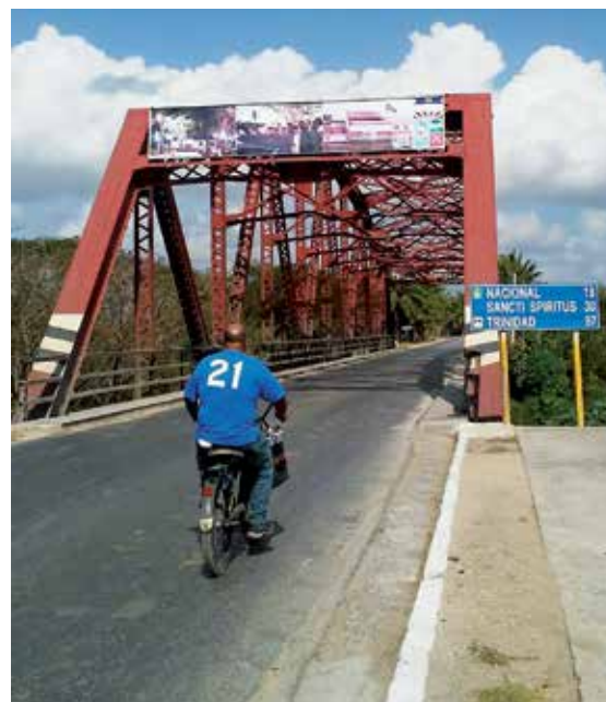
Resulta pertinente alargar la vida de la pasarela que enlaza el oriente con el occidente de la isla. /Foto: Yoleisy Pérez
