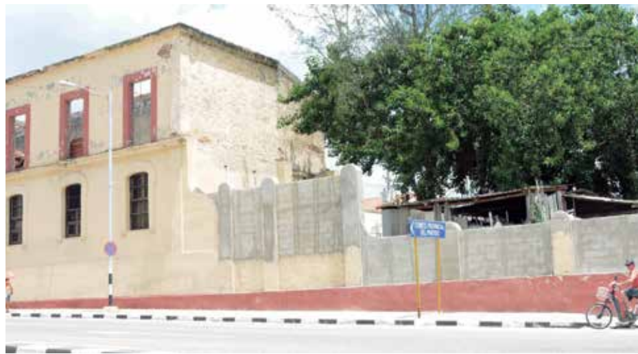
La rehabilitación del muro frontal figura entre las acciones reconstructivas. /Foto: Vicente Brito
