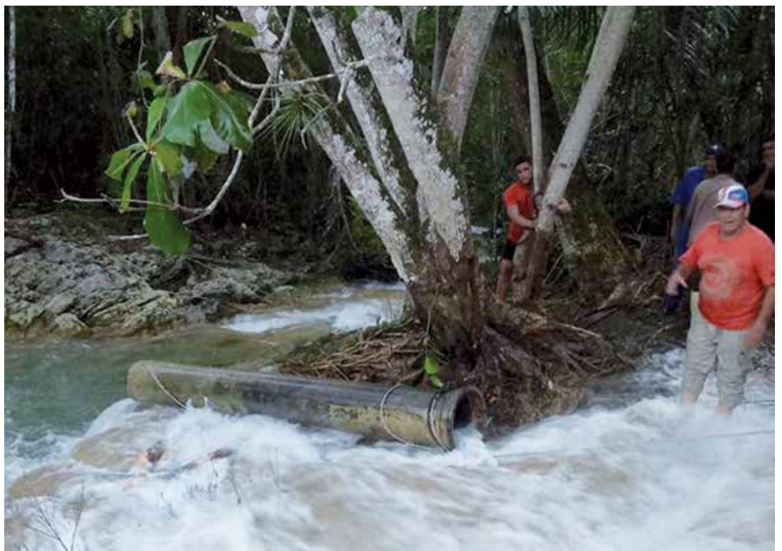
La rehabilitación de la conductora se realiza en condiciones extremadamente complejas. /Foto: Cortesía INRH
