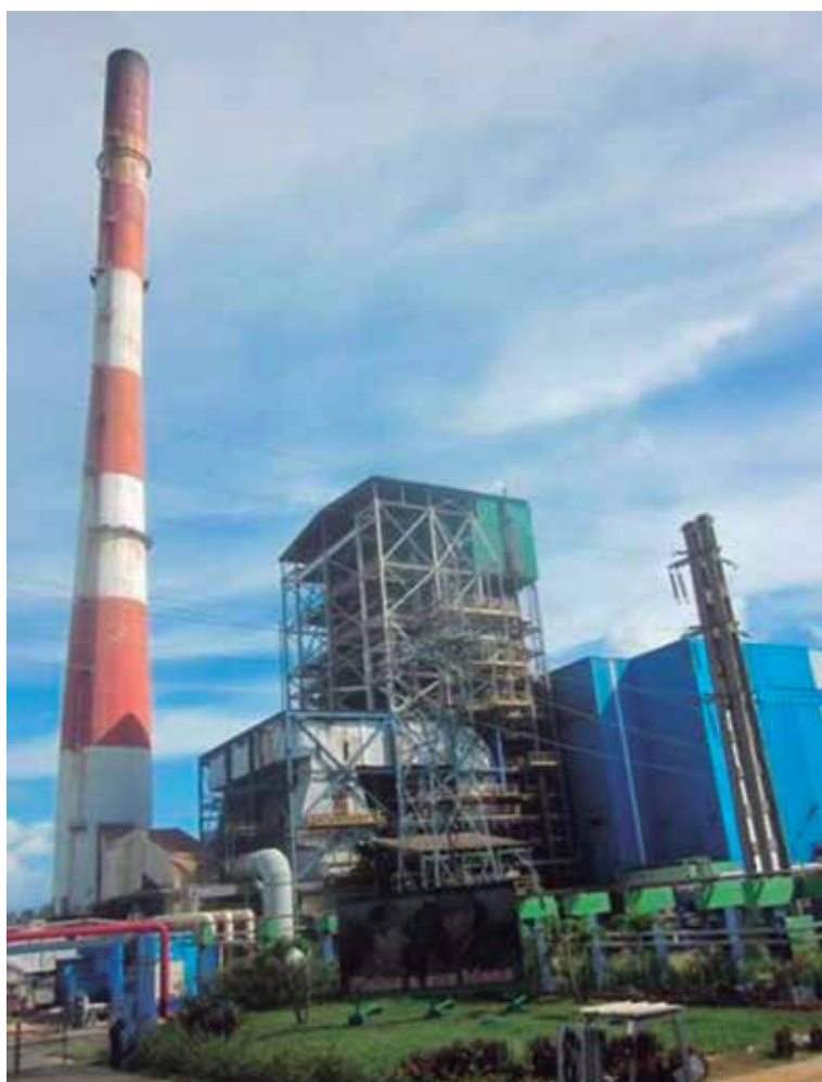
Las termoeléctricas cubanas muestran una marcada obsolescencia tecnológica. Foto: Hugo García
