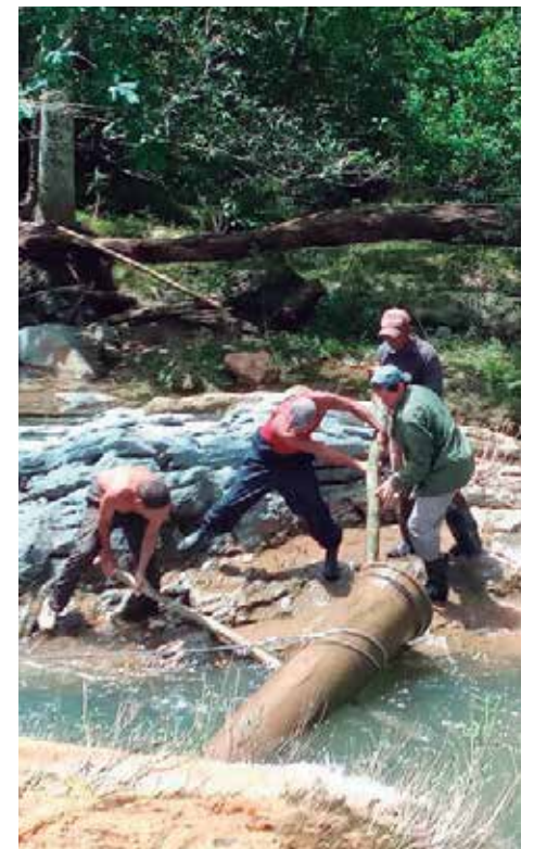
La primera operación es la extracción de uno de los tubos de hierro fundido.
