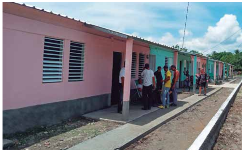
En un antiguo local ubicado en la comunidad de El Algarrobo se construyeron las cinco viviendas que responden a la dinámica demográfica.
