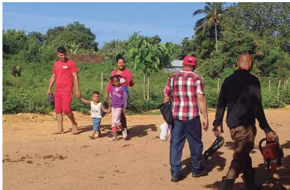
Los habitantes de El Caney agradecen la reparación de los viales que dan acceso a la comunidad.
