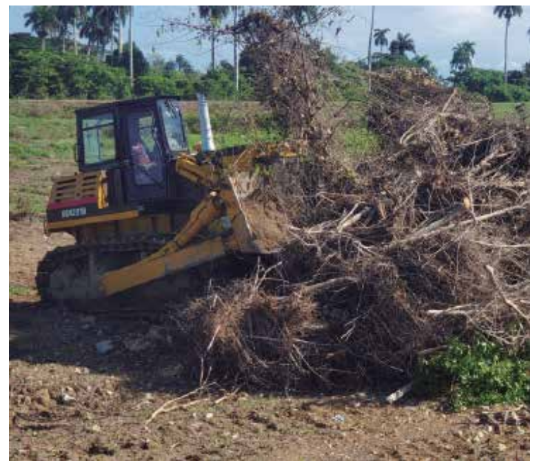
Actualmente se acometen trabajos de limpieza con el empleo de equipos pesados en los puntos más importantes para la evacuación de las aguas.
