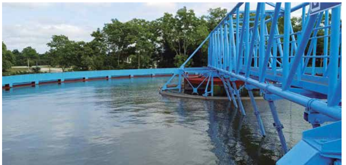
La planta está diseñada para trabajar 24 horas y está lista para iniciar un servicio regular a los clientes.
