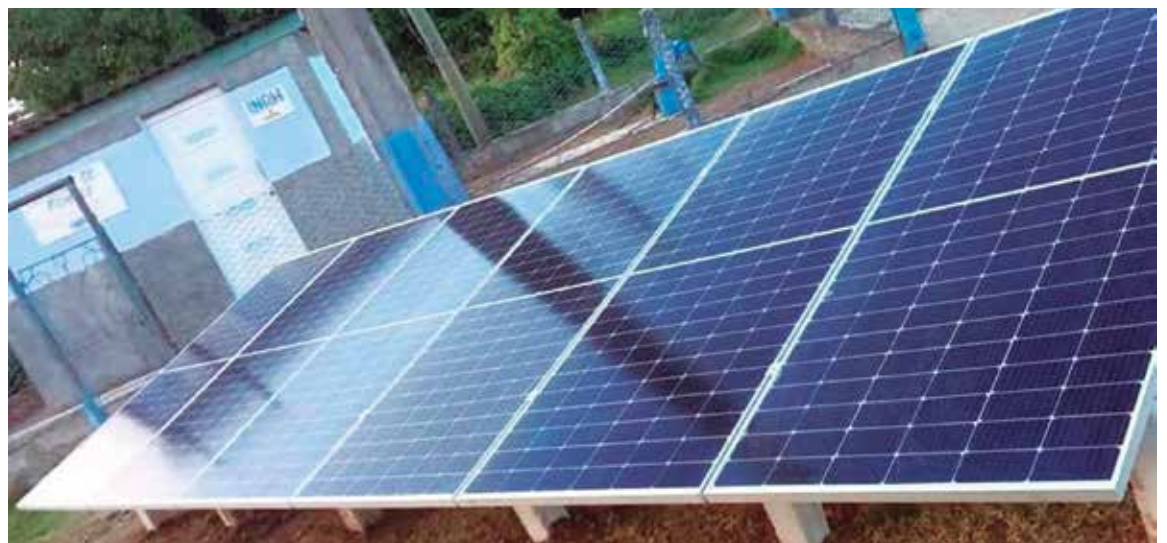
Montaje de paneles solares en la estación de bombeo Minas Abajo, en el municipio de Cabaiguán. /Foto: Recursos Hidráulicos
