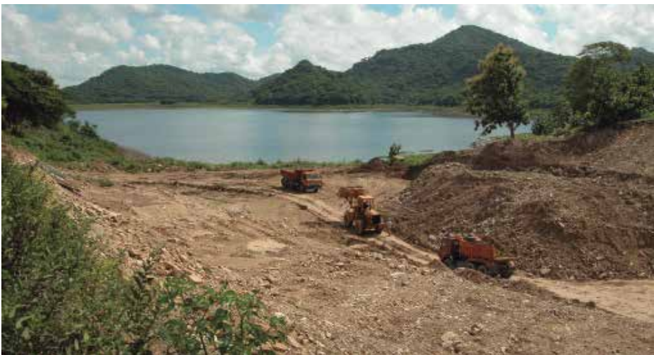
La construcción del nuevo aliviadero de la presa Lebrije fue una de las últimas obras encargadas a Amaro Cabrera. /Foto: Vicente Brito
