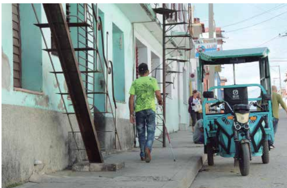
Construcciones fuera de los límites permisibles afectan el paso en calles y aceras.
