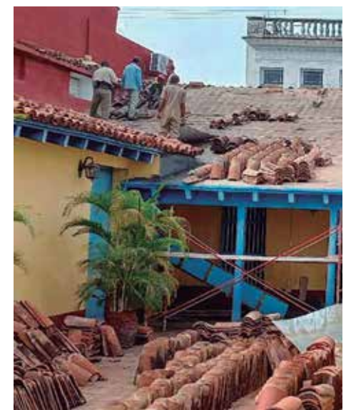
Todo el tejado se levantó para eliminar los orificios en la madera del techo.
