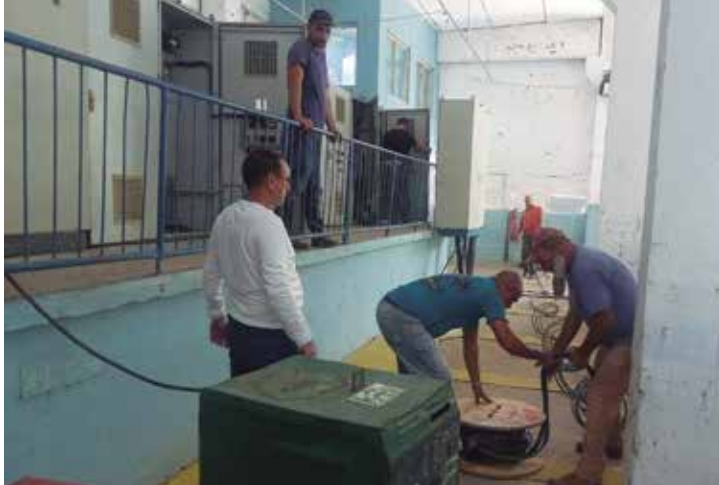
Trabajadores de varias empresas del territorio participaron en la instalación de los primeros equipos de bombeo. /Foto: Facebook
