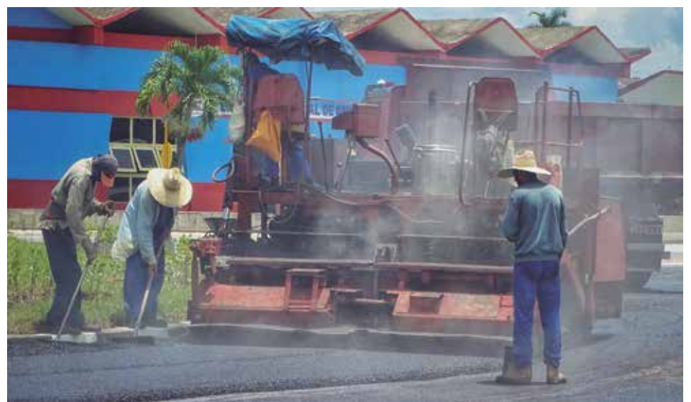
Por estos días se retomaron las labores que quedaron pendientes en la nueva rotonda.
