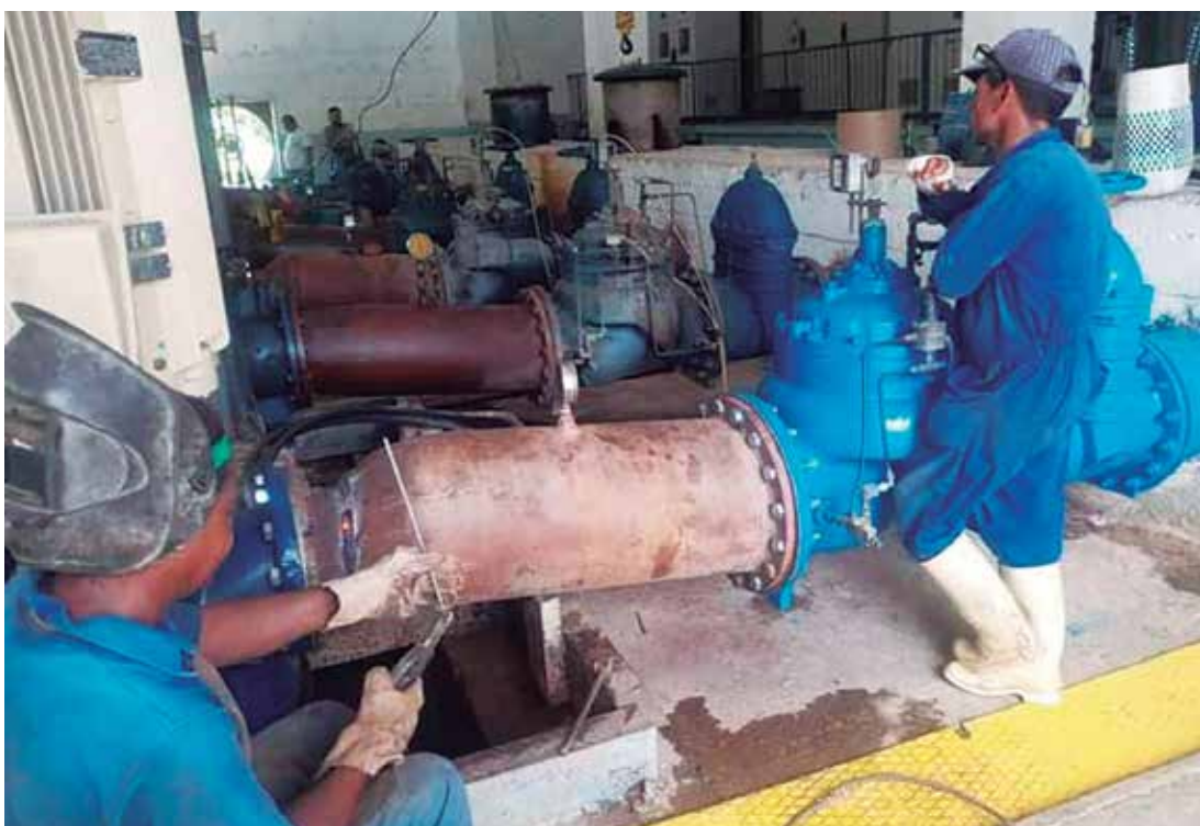
Los trabajos incluyeron adaptaciones, labores de pailería, protecciones eléctricas, certificación de las instalaciones, entre otros quehaceres. /Foto: Cortesía de la Empresa Provincial de Acueducto
