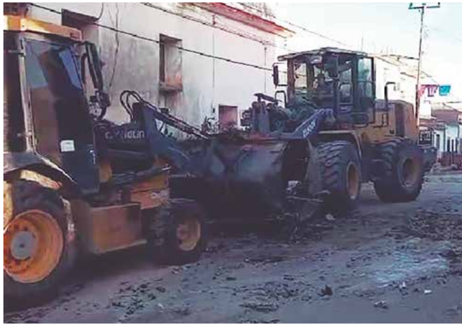
Constructores espirituanos participan en las labores de escombros y limpieza en la provincia de Artemisa /Foto: Facebook
