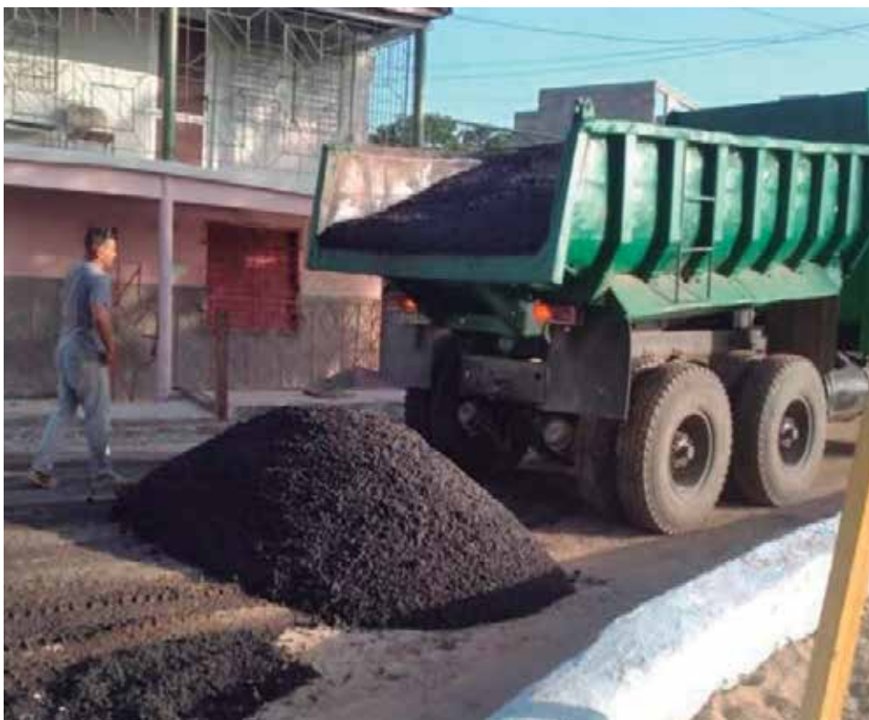
El mejoramiento de algunos viales figura entre las labores que se ejecutan en saludo a la fecha.
