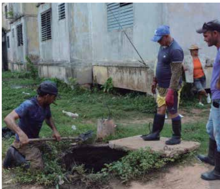
Los trabajadores de Alcantarillado de Jatibonico se enfrentan a situaciones complejas para limpiar los registros.
