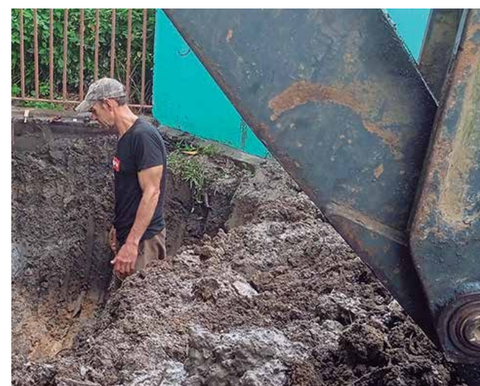
Fuerzas especializadas de la Unidad Empresarial de Base Acueducto y Alcantarillado de Sancti Spíritus asumieron las labores.
