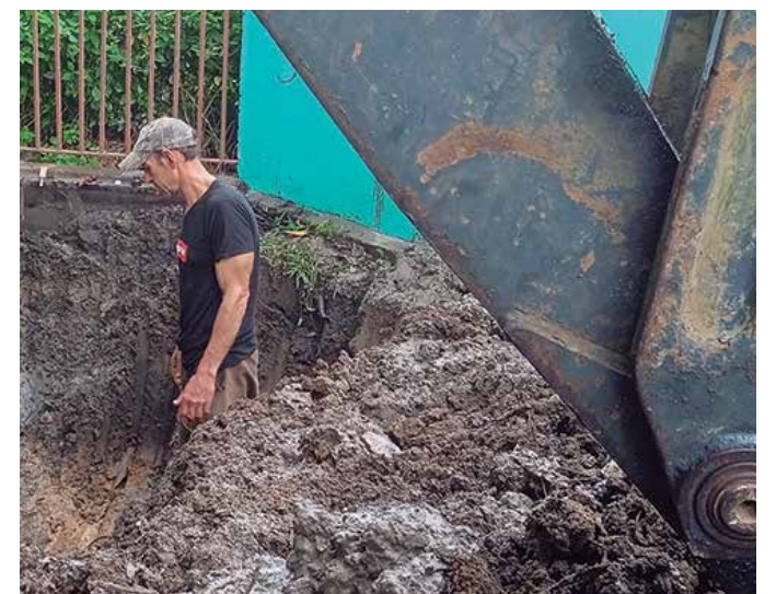
Fuerzas especializadas de la Unidad Empresarial de Base Acueducto y Alcantarillado de Sancti Spíritus asumieron las labores.
