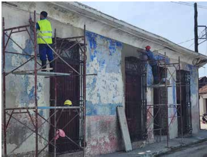
Las labores en la vivienda forman parte del proceso inversionista de la Oficina del Conservador de la Ciudad de Sancti Spiritus.
